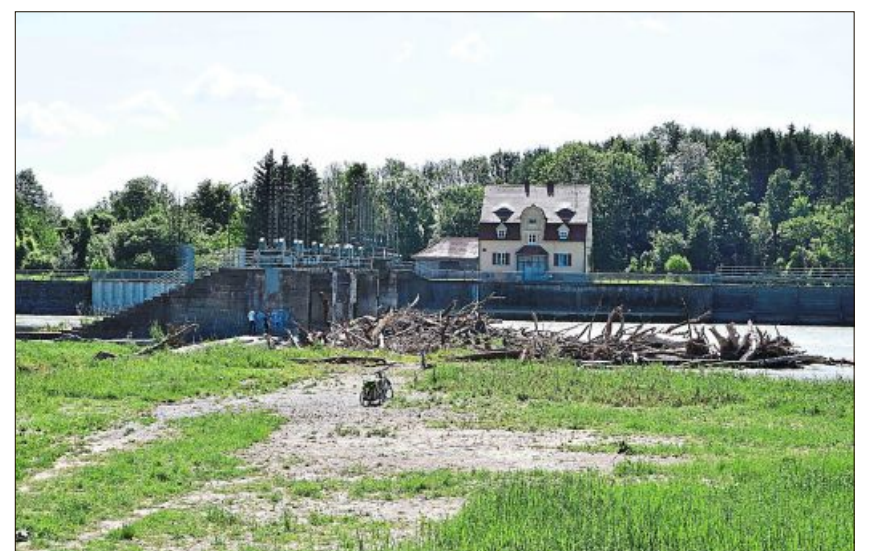
Am Moosburger Wehr wurde sehr viel Treibholz vom Hochwasser angeschwemmt.
